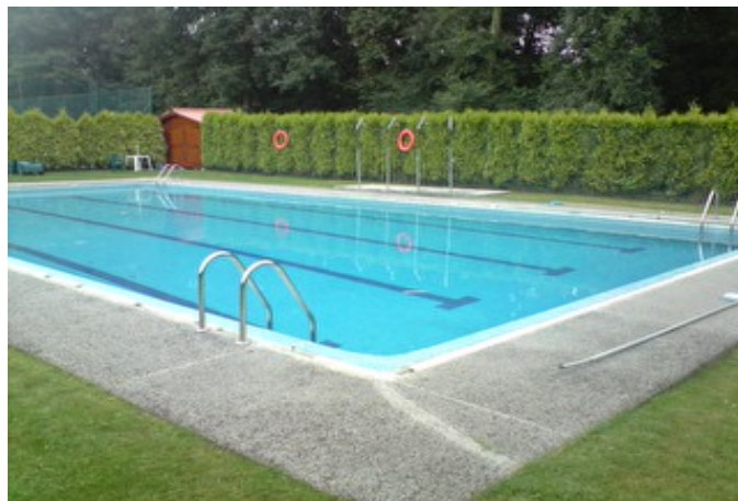
Ilustración 1. Vaso de agua reglado por la administración autonómica
